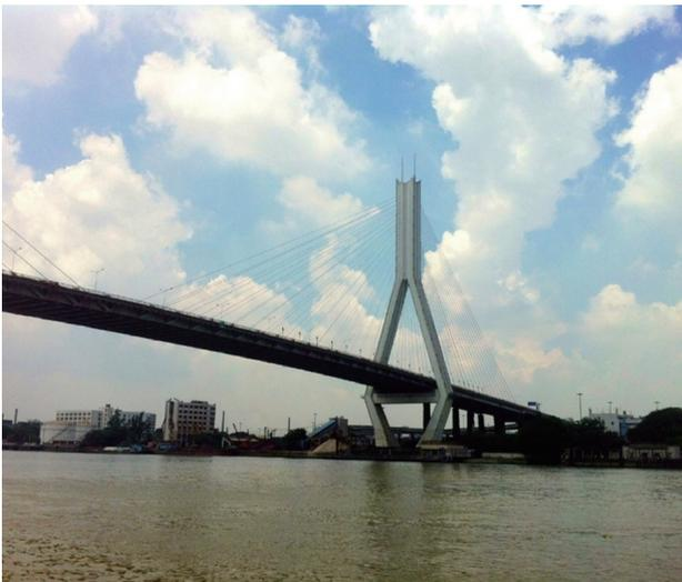
鹤洞大桥，位于广州市海珠区和荔湾区之间的珠江后航道上，东连海珠区昌岗路，西接芳村区鹤洞路，整个系统工程由主桥、东、西引桥，昌岗立交、广中立交组成，全桥总长 2440 米。主桥长 648 米，宽 30.3 米，设双向 6 车道和人行道（但没有设行人上下梯，引桥也不设人行道，实际上行人不能通行。），桥型为双塔双索面复合斜拉桥，主塔高 128.45 米，主跨为 360 米一跨过江的钢梁——钢筋混凝土板壳合结构，两侧副跨为 144 米的现浇预应力混凝土结构。桥梁设计荷载为汽—超 20、挂—120 验算，地震按七级裂度设防，设计车速为 60 公里 / 小时，通航净高 34 米。东引桥长 1196 米，西引桥长 596 米。
